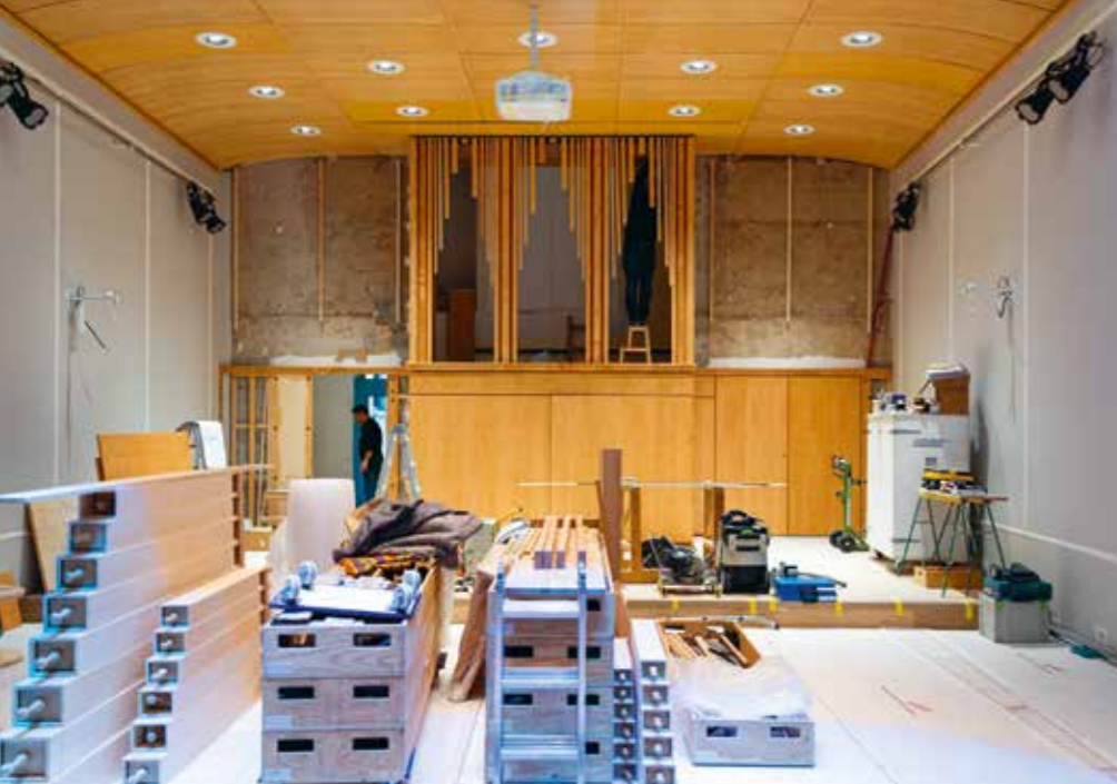
Kleiner Saal: Renovation und neue Saalorgel von Steinhoff/Zanin. Bühnenbereich beim Aufbau der Orgel; Detail des Pfeifenwerks im Inneren.
